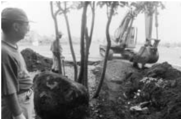
「ヌプリの森水」設置作業中の藤盛さん（左端）□
