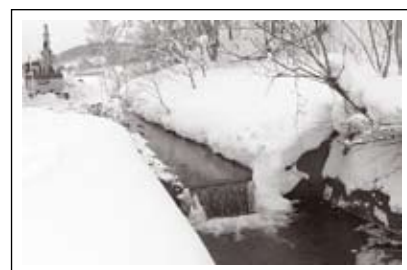
魚道工事前の俱登山第5号落差工(2010年1月13日)
