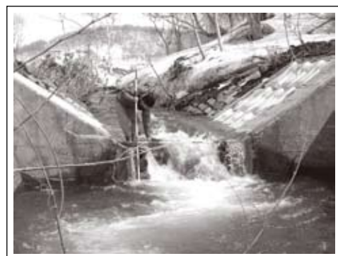
完成して初めての融雪増水期を迎えた第5号落差工魚道。本堤の直上流の右岸底部に置かれた大石(直径50センチ、ポールの右上)あたりの流速が1.9m/s程度で、これならイトウを含む遊泳魚は大石を回りこんで遡上可能です。(2010年4月16日)
