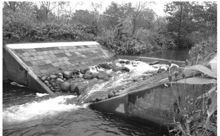
4号落差工に完成したセットバック斜路玉石張り側面傾斜タイプ魚道。2011年10月15日撮影。
