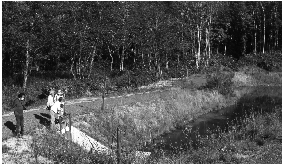
「ニセコまち」建設工事現場(上)と「LUPICIAニセコヴィレッジ」建設地の土砂貯留施設(下)を視察するオピラメの会員ら。撮影・平田剛士
